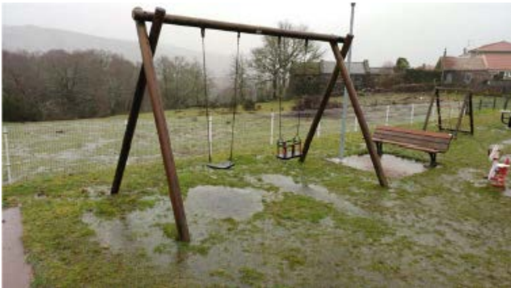
🚧 Detalles columpio: presenta asientos rotos y cadenas oxidadas
