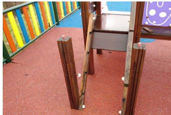
Detalles multijuego: presenta roturas, astillamiento y falta de material
