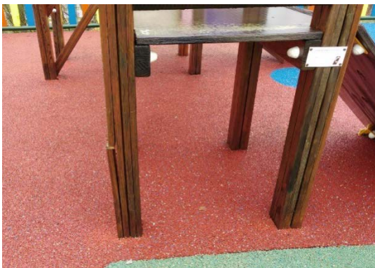
Detalles multijuego: presenta roturas, astillamiento y falta de material
