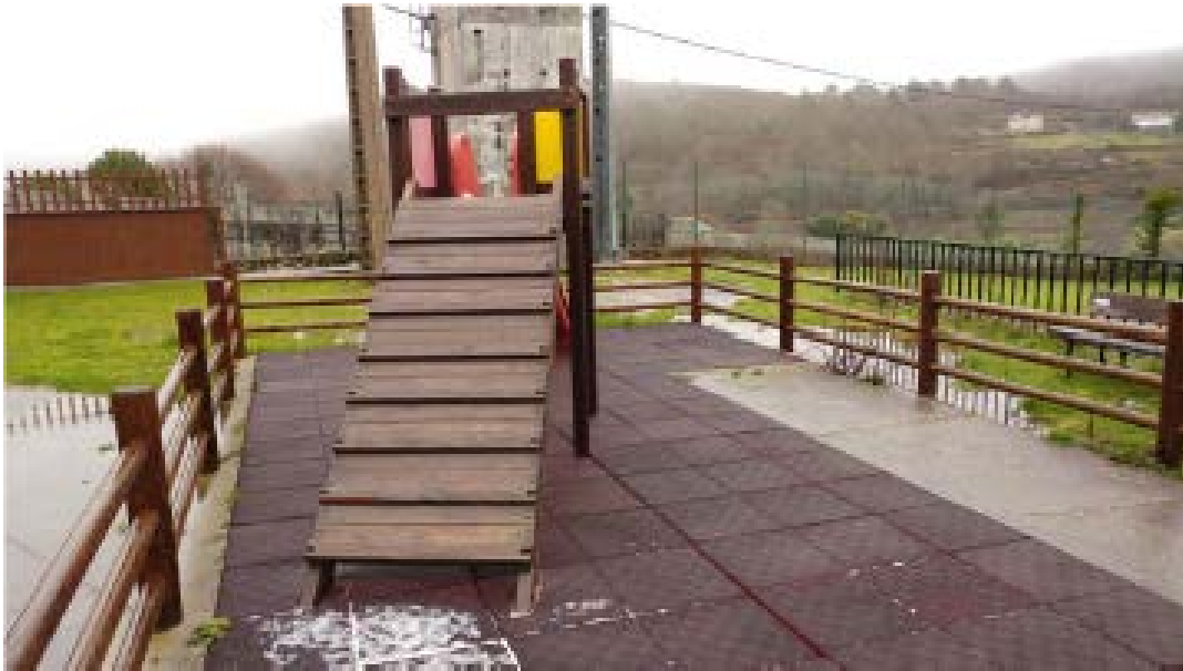
🚧 Detalles pavimento: falta de material
